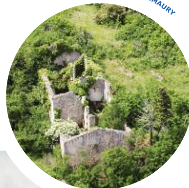
SITE DE VILLEMAURY
